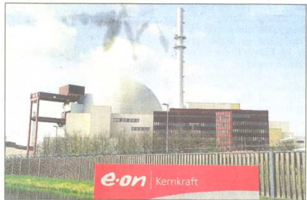
Das Kernkraftwerk des Betreibers Eon in Brokdorf an der Unterelbe. Foto: Rehder
