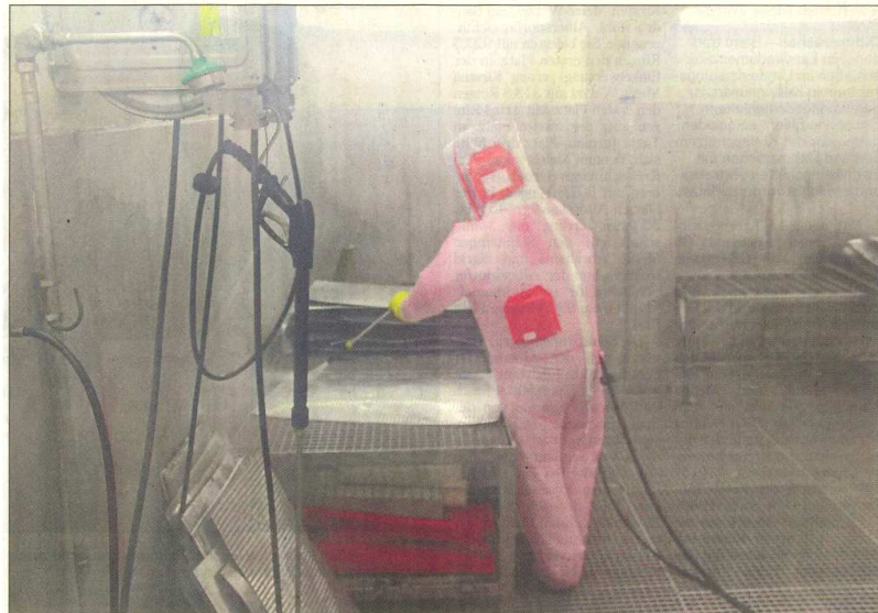
Ein Mitarbeiter reinigt in der sogenannten Dekontaminations-Box ein Blech mit einem Hochdruckreiniger. Foto: Vattenfall
