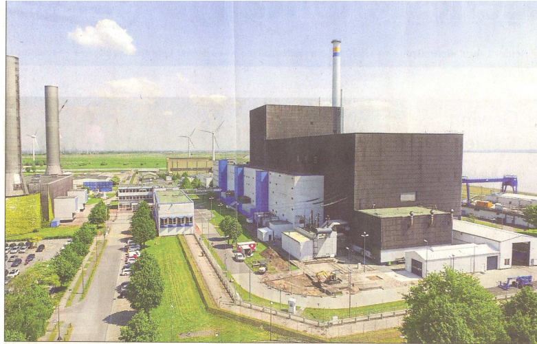
Das Kernkraftwerk in Brunsbüttel soll abgebaut werden. Für die Zwischenlagerung radioaktiver Abfälle soll auf dem Betriebsgelände eine Lagerhalle errichtet werden.
