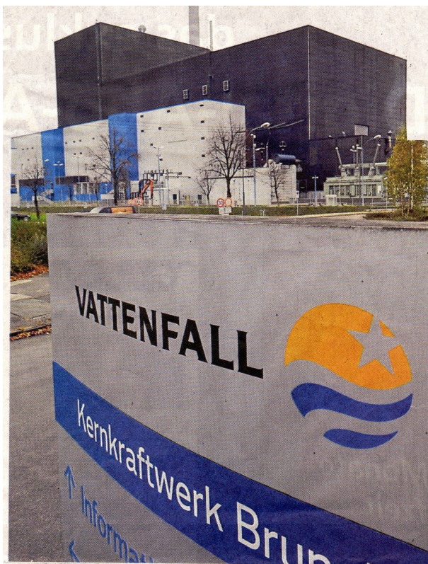
Bevor an der Stelle des stillgelegten Atomkraftwerks in Brunsbüttel wieder eine grüne Wiese gewachsen ist, werden noch viele Jahre vergehen. Foto: Rehder
