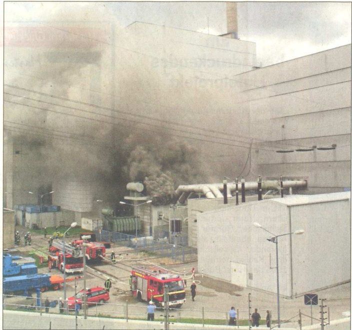
Feuerwehrlöcher löschen am 28. Juni 2007 einen Brand an einem Trafostation des Atomkraftwerks Krümmel. Foto: Jann
